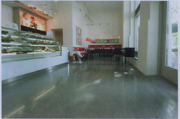
HTC Superfloor™ in einer Bäckerei in Norwegen
