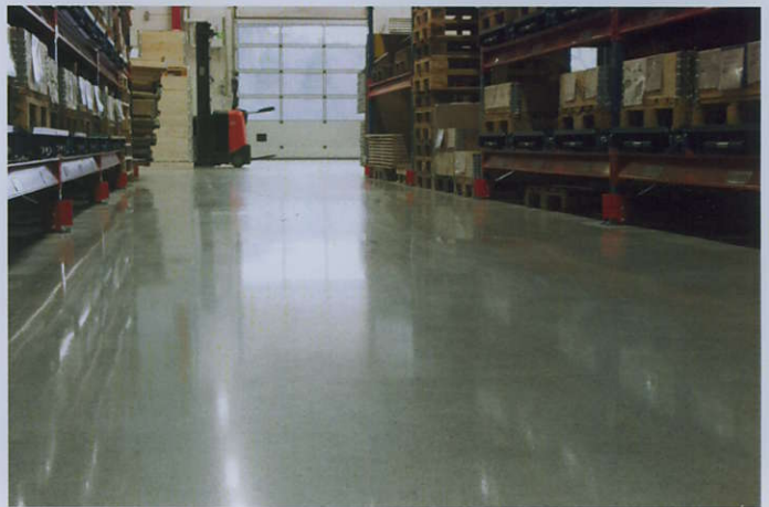
HTC Superfloor™-Methode in einem Lagerhaus in Schweden
